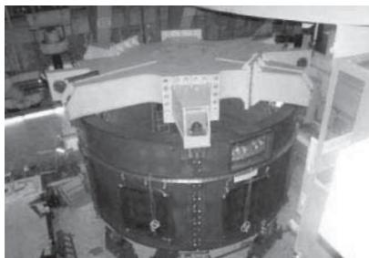
*Stator generatora B, montiran na montažnom katu strojarnice premješten je u strojarnicu*
